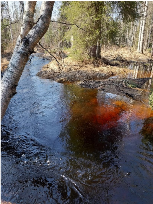
Kuva 7. Poikkiojan alaosalla uoma toimii luonnollisesti tulvavedellä. Mutkittileva uoma ja virtaus siirtää kiintoainetta uoman penkoille sekä luo sivu-uomia tarvittaessa.
