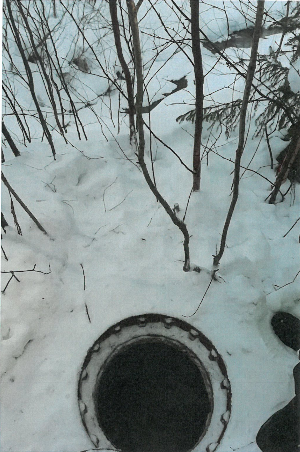
Kuva 4. Viemäri­linjan tarkastus­kaivon vieressä oleva ylivuotokaivo, josta menee suoraa putki taustalla olevaan ojaan (9.1.2023).
